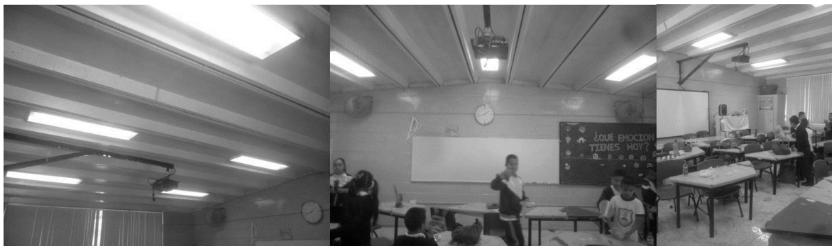
Figura 30: Implementación de los dispositivos de iluminación circadiana en experimentación (Elaboración propia, 2020).
